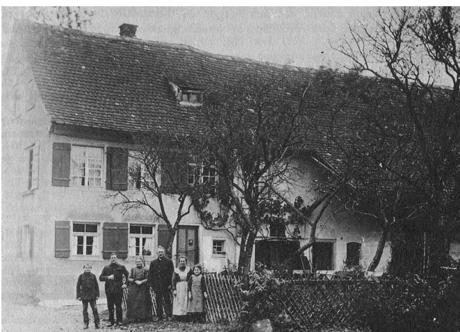
Abb. 31a. Wohnhaus u. Atelier Andreas Bruggers (Haus 114, Langenargen; abgebrochen)
